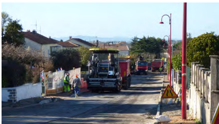
Travaux de goudronnage rue Général de Barry
