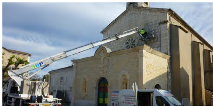
Restauration de la façade de l'église Saint André
