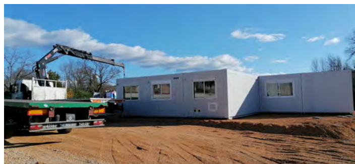
Livraison des préfabriqués pour l'accueil du centre de santé Filiéris
