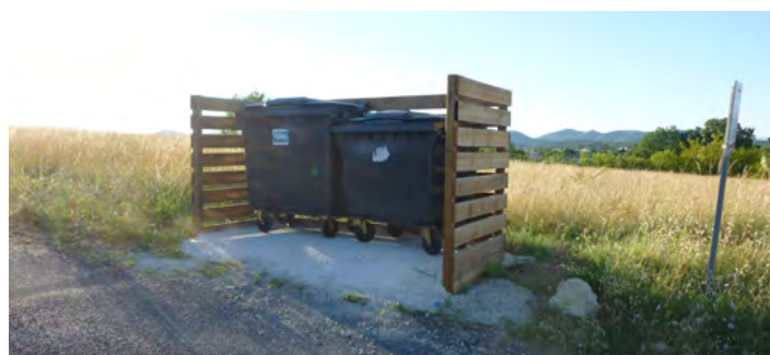
Réalisation de protège containers
