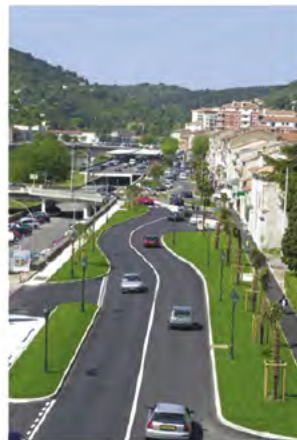
Éclairage avenue Carnot et parkings inférieurs d'Alès
