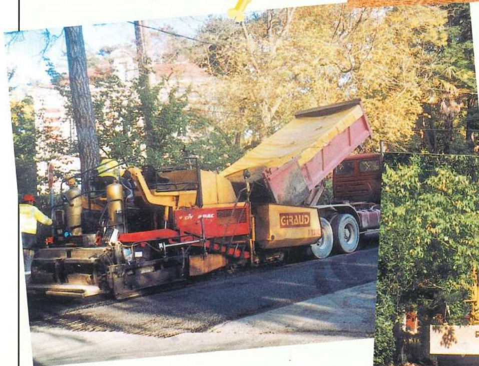
Suite aux inondations, remise en état de l'avenue du Parc et pose d'un tapis bitumineux.
