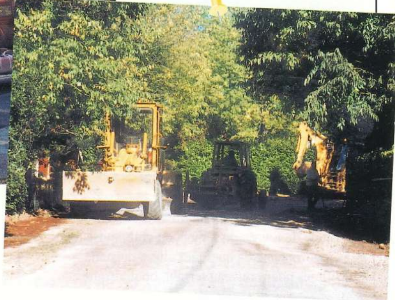
Suite aux inondations, remise en état de l'avenue du Parc et pose d'un tapis bitumineux.
