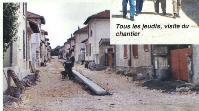
Comme dans la rue H. Merle, un caniveau central recueillera les eaux de la rue à double pente
