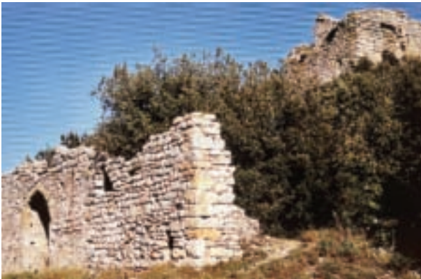
La Tour Bécamel avant que la Commission Environnement ne programme les travaux de sa réhabilitation
