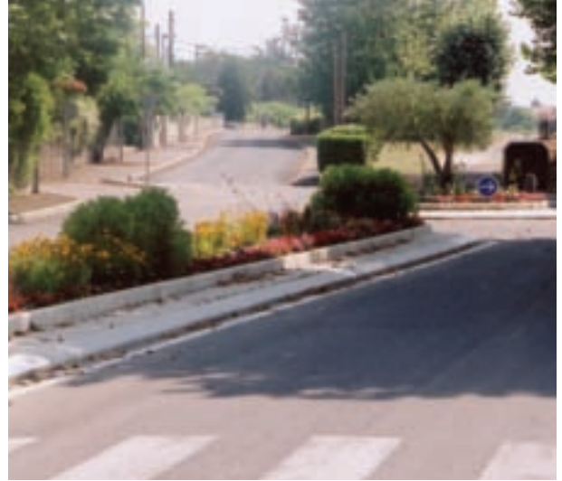
La sortie du pont rond point "petite vitesse" sécurisée est embellie.
