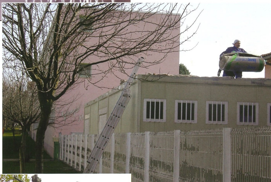
Pose d'une isolation et d'une double toiture sur les bungalows des écoles
