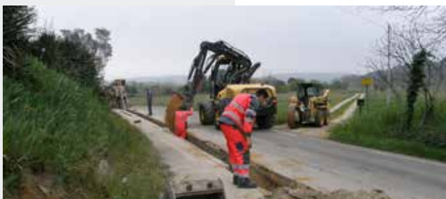
Renforcement réseau d'eau potable rte de Mazac
