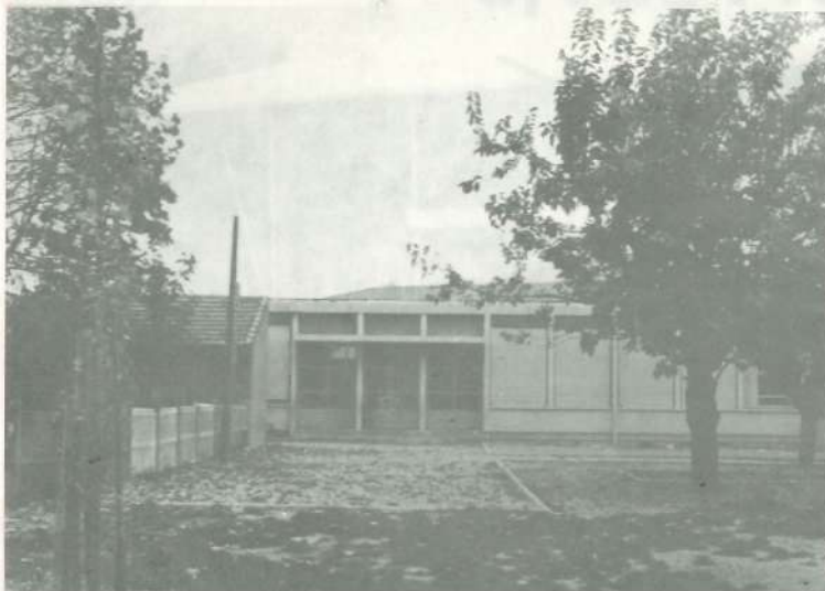
Cour et bâtiment de l'Ecole Maternelle.
