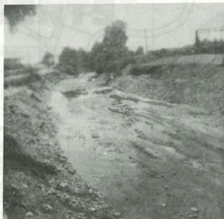
Vue du recalibrage et curage de l'Avène.
